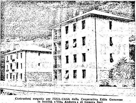
Costruzioni eseguite per l'INA-CASA dalla Cooperativa Edile Genova...
